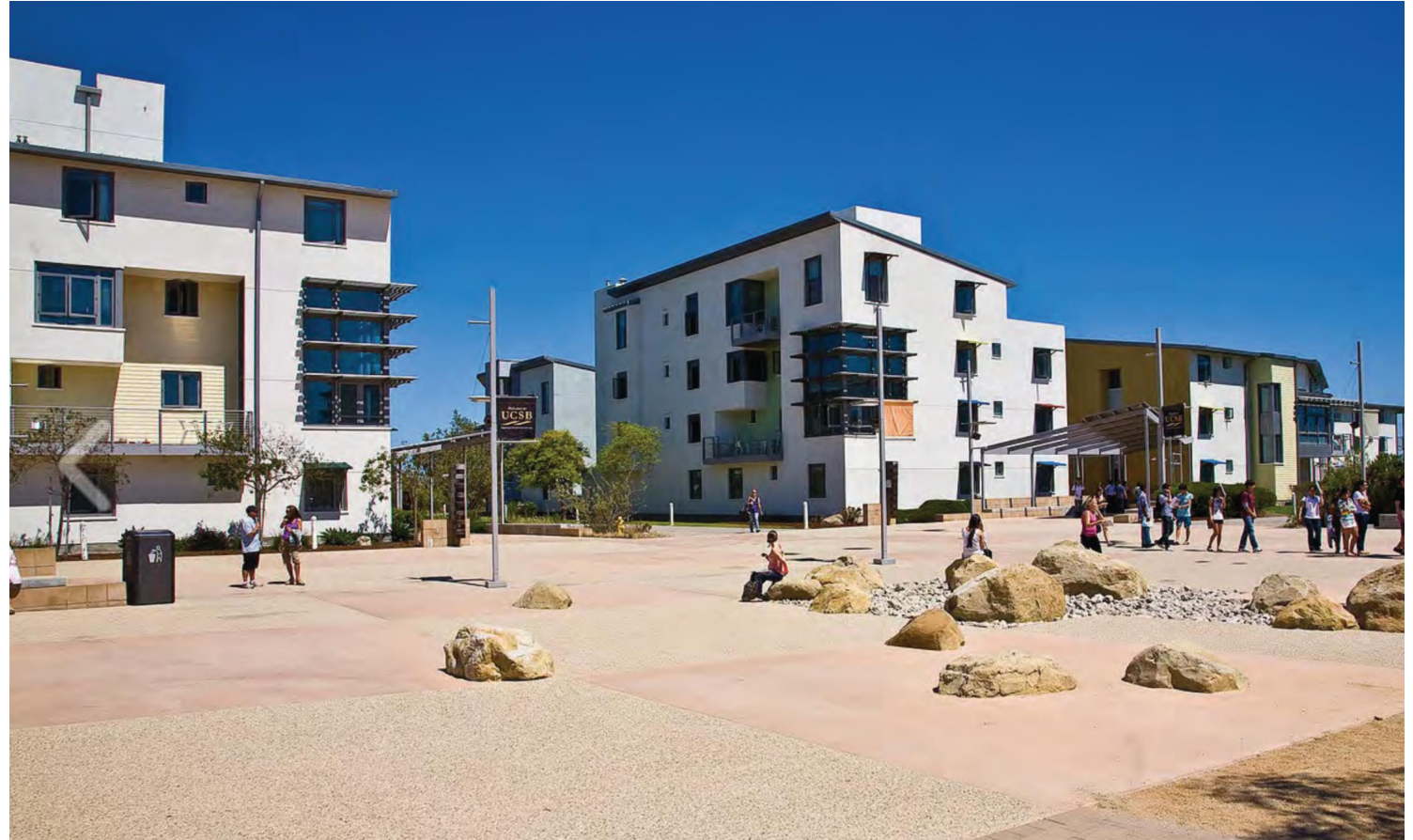
Strong Contemporary Roof Form & Corner Element / Un Volumen, Techo y Elemento de Esquina Contemporaneos
